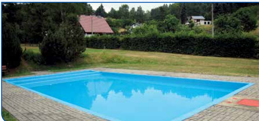
Das alte Betonbecken (10 x 8 m) ohne Aufbereitungsanlage, gestrichen mit Chlorkautschukfarbe
