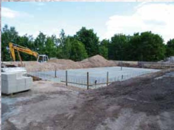
*Gießen der stahlbewehrten Bodenplatte mit Beton C 25*
