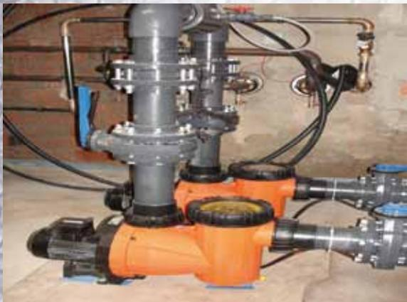
*Einbau neuer Pumpen mit dazugehöriger Verrohrung*
