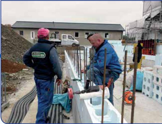
Für den Aufbau der Beckenwände wurden anschließend ISOSTONE Styroporsteine (Hersteller: PSG Pumpen GmbH) im Verbund aufgebaut und ebenfalls mit Stahl armiert. Dieses System zeichnet sich durch eine besondere Isolierungswirkung und Flexibilität aus.
