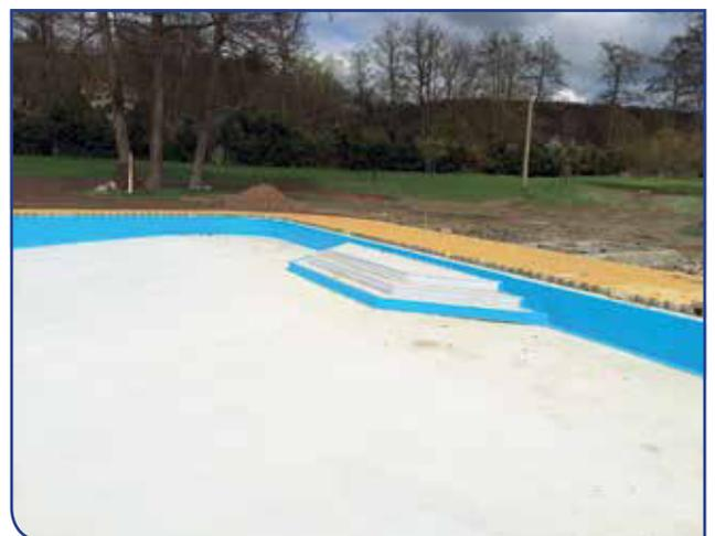
Nachdem das „Innenleben“ der Becken fertig gestellt war, galt es die Beckenumgänge aufzufüllen sowie die Wege und Aufenthaltsflächen fachgerecht mit 1700 m<sup>2</sup> Pflaster zu versehen. Der Beckenkopf wurde als Abschluss zu den Beckenwänden mit insgesamt 520 gewölbten Beckenrandsteinen, die gleichzeitig als Handfasse dienen, abgedeckt.
