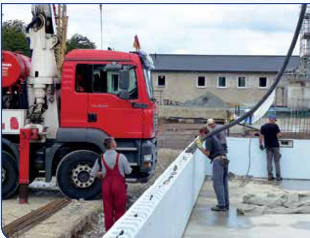
In Vorbereitung auf den Betonverguss der Schalsteine wurden alle weiteren Einbauteile (Einlaufdüsen, Breitmaulskimmer, etc.) mit entsprechender Verrohrung eingesetzt. Das Einfüllen des Betons erfolgte mittels Betonmischwagen. Insgesamt wurden 400 m<sup>2</sup> Beckenwände mit dieser Bauweise hergestellt.
