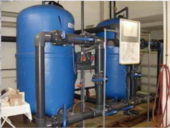
Einbau der neuen Filter inklusive der dazugehörigen Verrohrung sowie des Schaltfeldes
