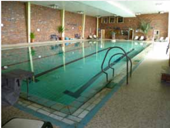
Fliesenbecken des Hallenbades vor der Sanierung
