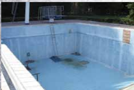
Nichtschwimmerbecken vor der Folienauslegung
