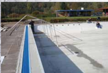
Vorbereitung für die Folienauslegung der Einstiegstreppe und der Überlaufrinne
