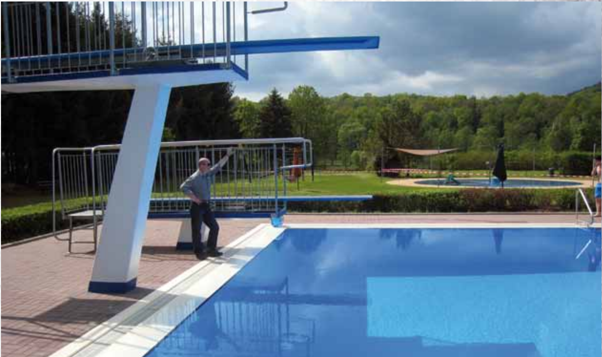
Freibad Waldkappel mit saniertem Schwimmer-, Springer- und Nichtschwimmerbecken
