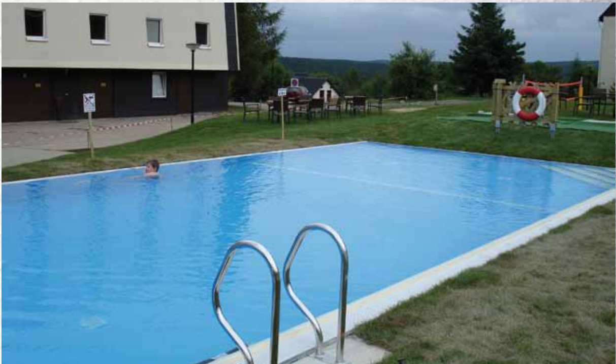
neu errichtetes Kombibecken im Außenbereich
