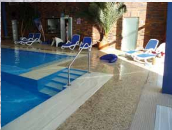
Fertiggestellter Beckenum- gang mit Überlaufrinne und Treppeneingang. Die Ausklei- dung erfolgte mit beiger Trittschulzfolie
