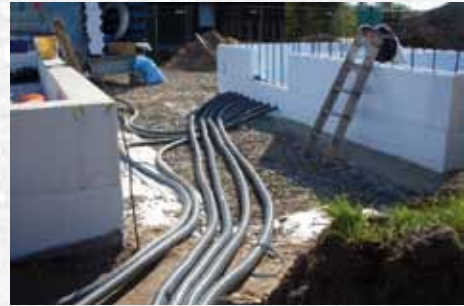
Anbringung der Einströmungsleitung und der Unterwasserbeleuchtung am Beckenkörper
