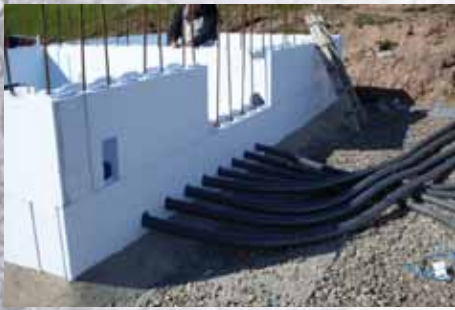
Verlegung der Rohrleitungen vom Schwallwasserbehälter zum Schwimmerbecken und zur Technik
